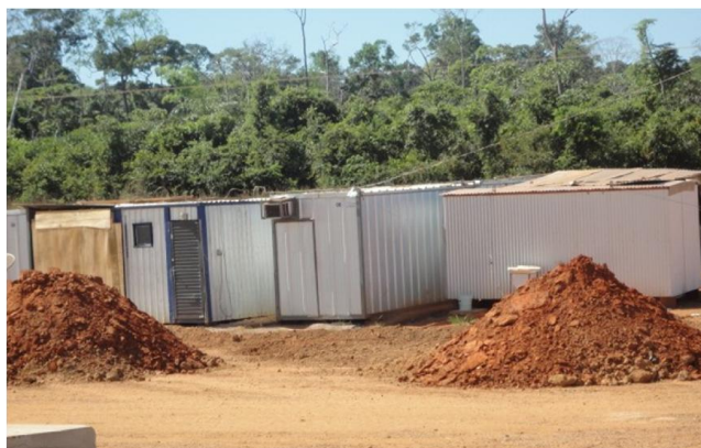
Figura 12- Banheiros Provisórios Fonte: Própria (2014)
