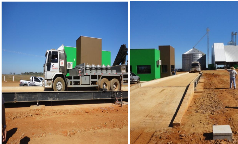
Figura 1 – Estrutura Física: Recepção e Pesagem Fonte: Própria (2014).
