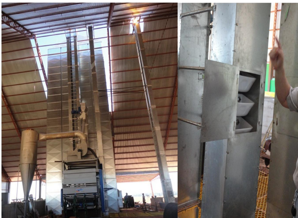
Figura 6 – Estrutura Física: Elevador Fonte: Própria (2014).
